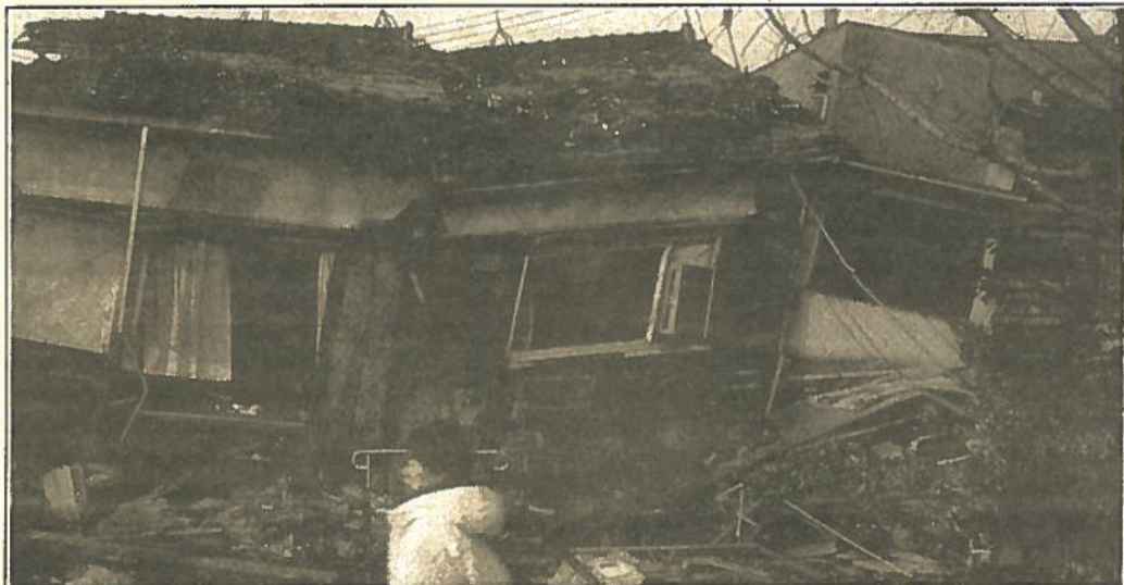
Miles de estructuras colapsaron en el terremoto de Japón dejando un cuadro de desesperación ante la tragedia.
